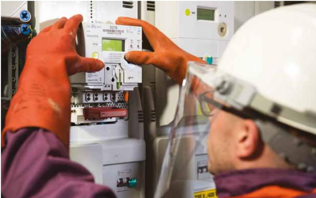
*Lorsqu'il opère un nouveau raccordement, Sibelga pose désormais des compteurs d'électricité électroniques Smart Read, techniquement prêts à communiquer. Les fonctions à distance des compteurs ne seront pas activées tout de suite, d'où leur nom de Smart Ready.*
